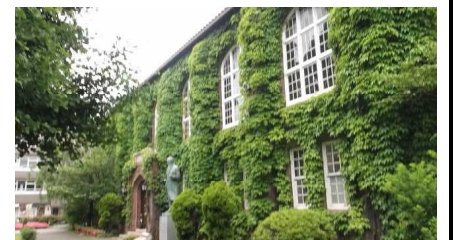
ツタの絡まる図書館旧館
